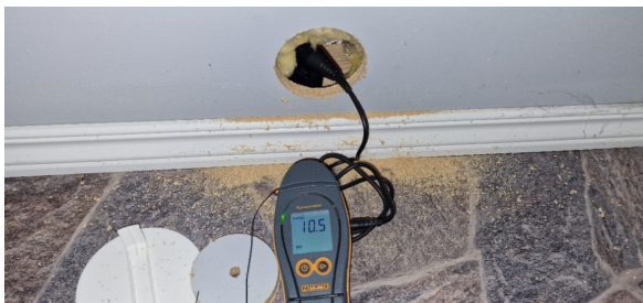
Hulltaking og fuktmåling i gangen.
