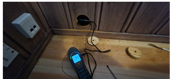
Hulltaking og fuktmåling.
