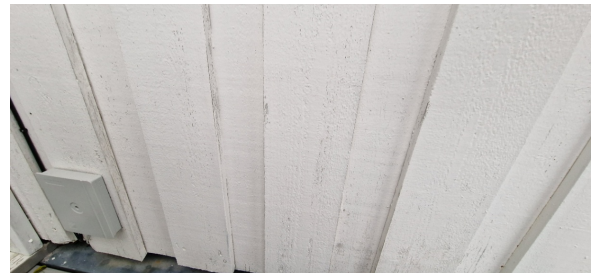
Malingsflass/slitasje.
