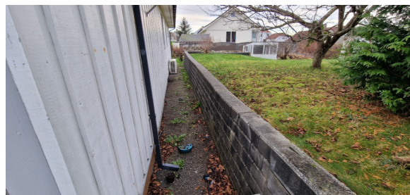
Manglende rekkverk/sikring.
