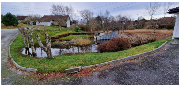
Stående vann på eiendommen mot vest.
