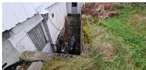
Manglende rekkverk/sikring.
