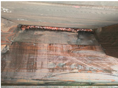
Tett mellom sperrer og undertak i 2. etg (hybel).
