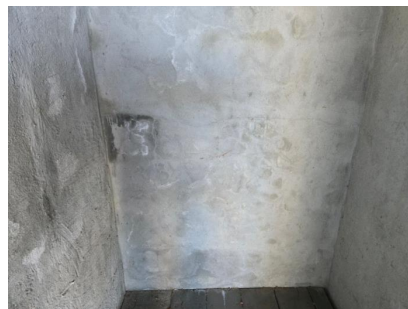
Bilde fra bod utenfor leilighet i underetasjen.
