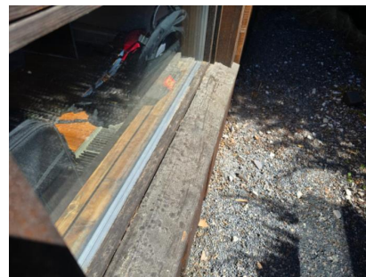
Feil i løsnung under vindu i 1. etg.
