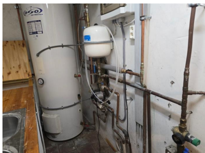
Bereder på bad i underetasjen.
