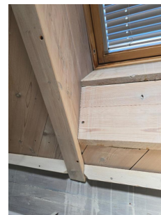
Feil i løsnung under vindu i 1. etg.
