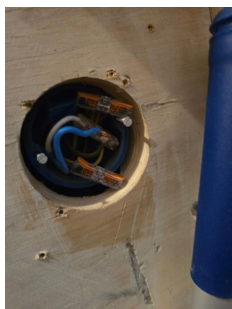
Koblingspunkt uten deksel i leilighet i 2. etg.
