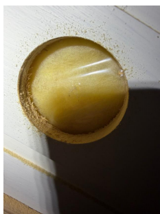
Bildet viser bruk av dampsperre i vegg under terreng.
