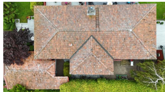
Bildet viser oversikt over taktekking.
