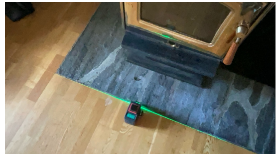
Ildfast plate under ovn i stue er for kort.
