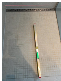
Fall i dusj. Det er målt 5mm fall på 80cm.
