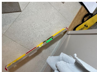
Fall i dusj. Det er målt 5mm fall på 80cm.
