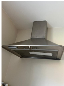
Test av avtrekksvifte på kjøkken i kjeller
