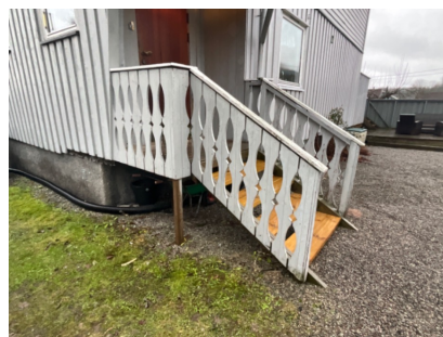
Trapp ved inngangsparti.
