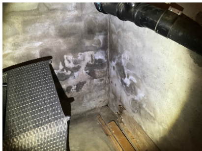
Synlige skjolder/avskalling av maling, indikasjon på fukt.
