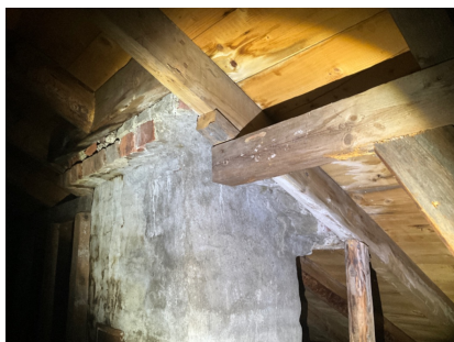
Fuktskjolder rundt pipen, det ble ikke påvist fukt ved befaringen
