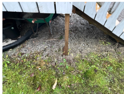
Provisorisk fundament på trappen.
