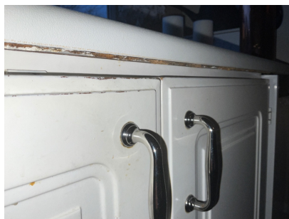
Bruksslitasje og noe svelling i benkeplaten.
