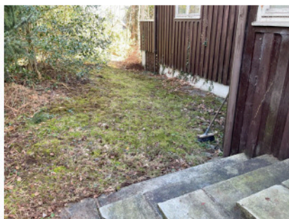
Terreng på overside har fall mot mur.
