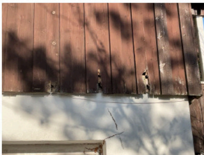
Råteskadet bordkledning.
