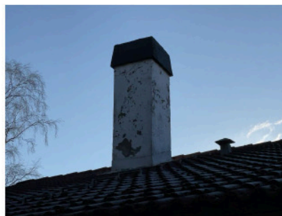
Malingsavflassing på pipe over tak.
