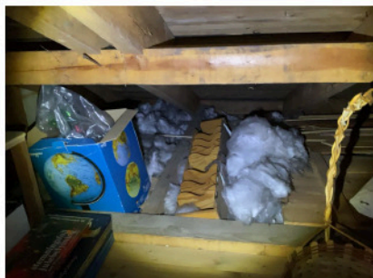
Glassvatt/isolasjon som ligger i uorden.
