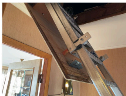
Enkel/uisolert loftsluke.
