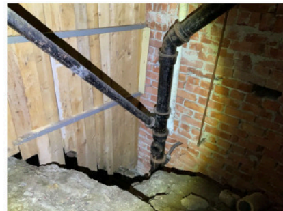
Soilør med stakemulighet sett i krypkjeller.
