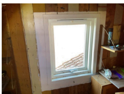
Nyere vindu på loft.
