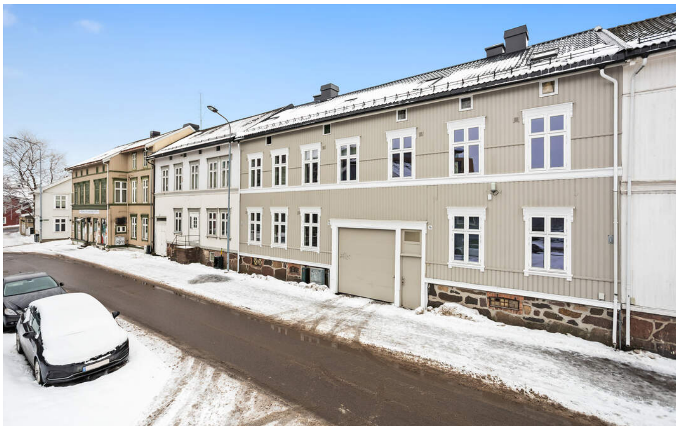
Sameiet er bestående av 6 leiligheter. Inngang via dør eller port. Parkering i bakgården.
