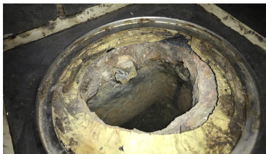
Bildet viser sluk.
