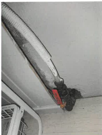
Bilde 1 Hovedjordelektrode
