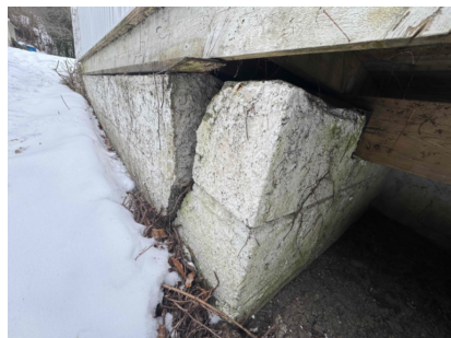
Støttemur under veranda
