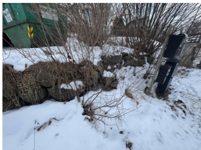
Støttemur mot veg
